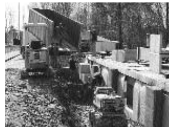
Das Untergeschoss ist fertig, verfüllen der Baugrube, Ende März.
