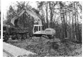
Ausbaggern der Baugrube, am 12. Januar.
