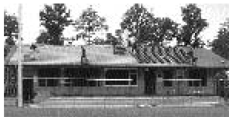
Dachdeckerarbeiten, Einbau der Fenster, Anfang Mai.
