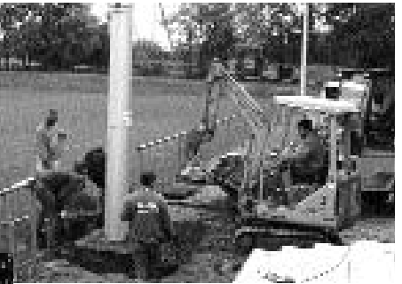
Das Fundament des Flutlichtmastens wird neu betoniert
