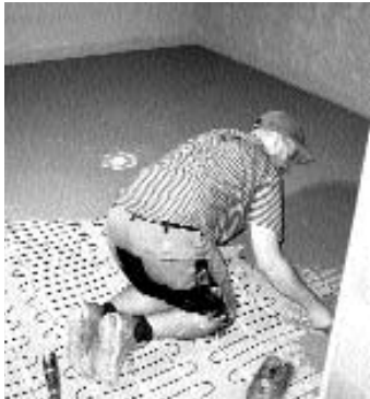
Einbau der Fußbodenheizung
