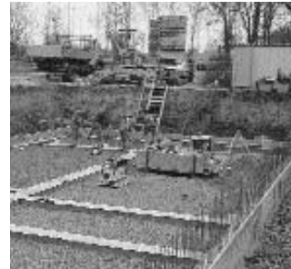
Bodenplatte mit den Fundamenten, im Februar.
