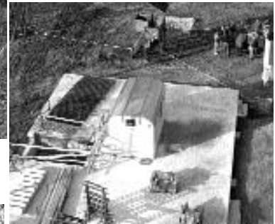
Bodenplatte ist fertig, der Rohbau beginnt im April
