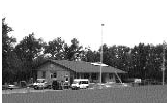
Der Innenausbau ist in vollem Gange, die Solarthermie ist installiert.
