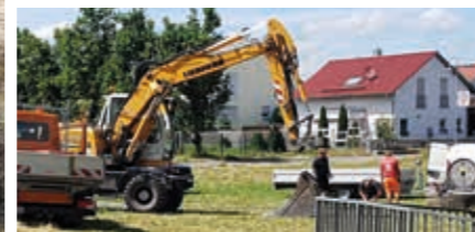
Bauhof und Firma Kenngott tauschen die Brunnenpumpe der Beregnungsanlage beim Trainingsplatz.
