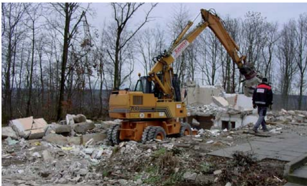
Abriss vom Sportheim im Januar 2007
